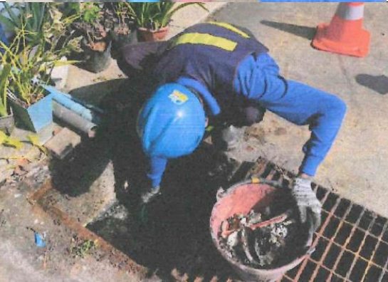
รูปที่ 2-10 การดูแลทำความสะอาด ขุดลอกท่อและวางระบายน้ำภายในพื้นที่โครงการ
