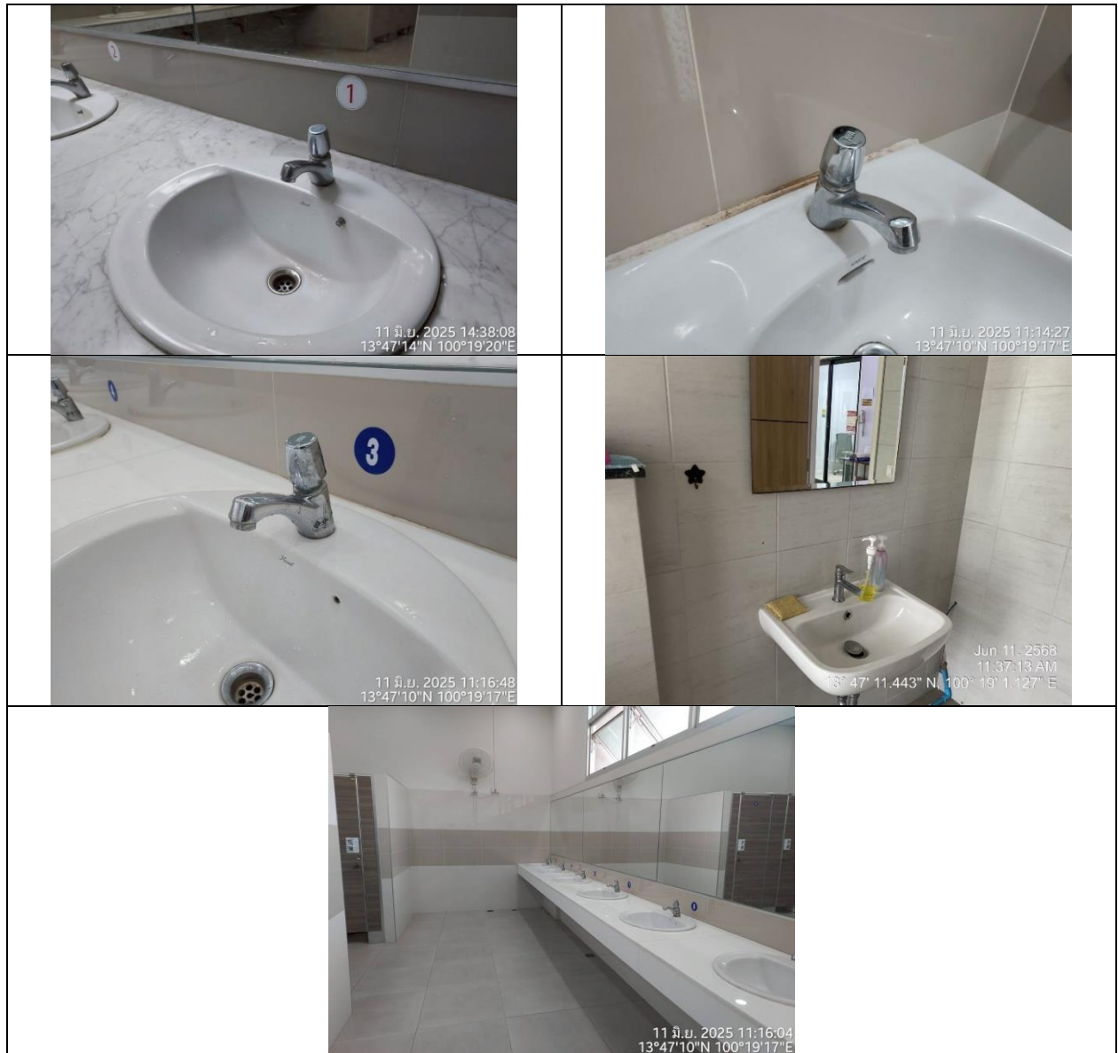
รูปที่ 2-7 การติดตั้งก๊อกน้ำประหยัดน้ำ
