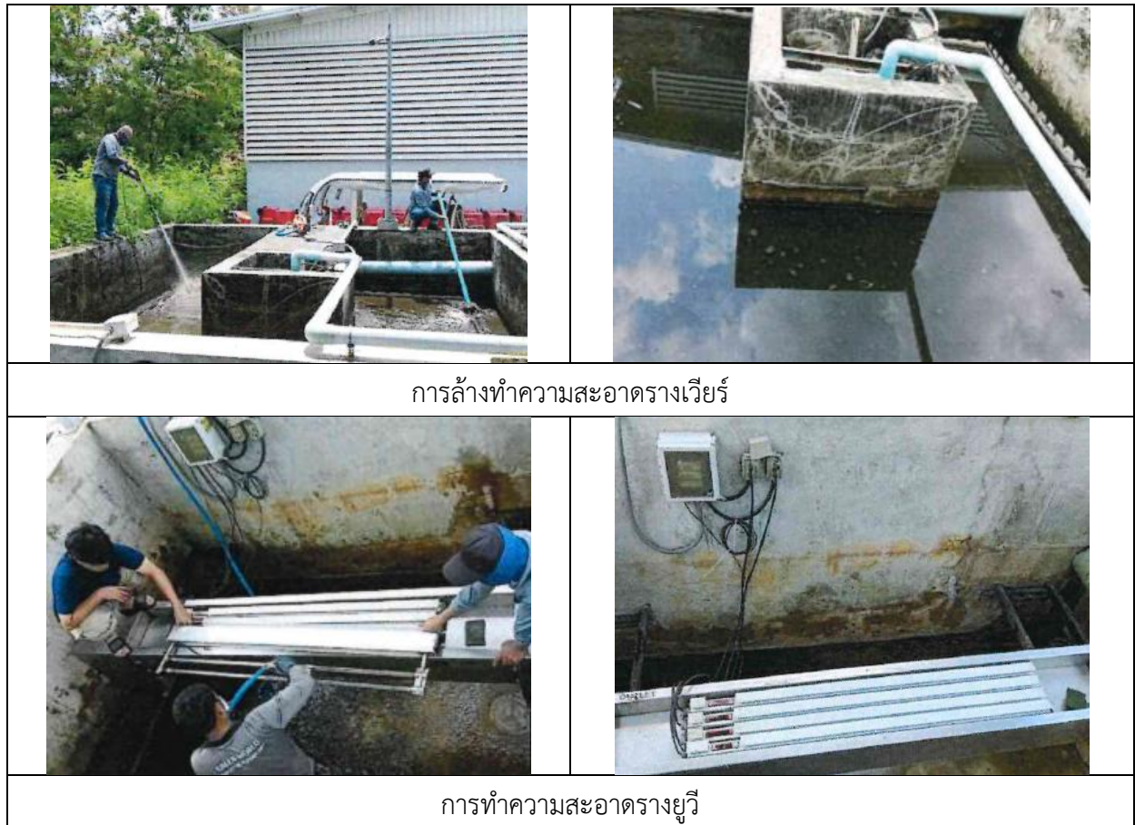
รูปที่ 2-4 สภาพปัจจุบันของระบบบำบัดน้ำเสียและการตรวจสอบดูแลระบบบำบัดน้ำเสียของโครงการ (ต่อ)
