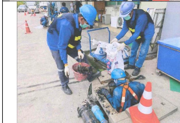
รูปที่ 2-10 การดูแลทำความสะอาด ขุดลอกท่อและวางระบายน้ำภายในพื้นที่โครงการ
