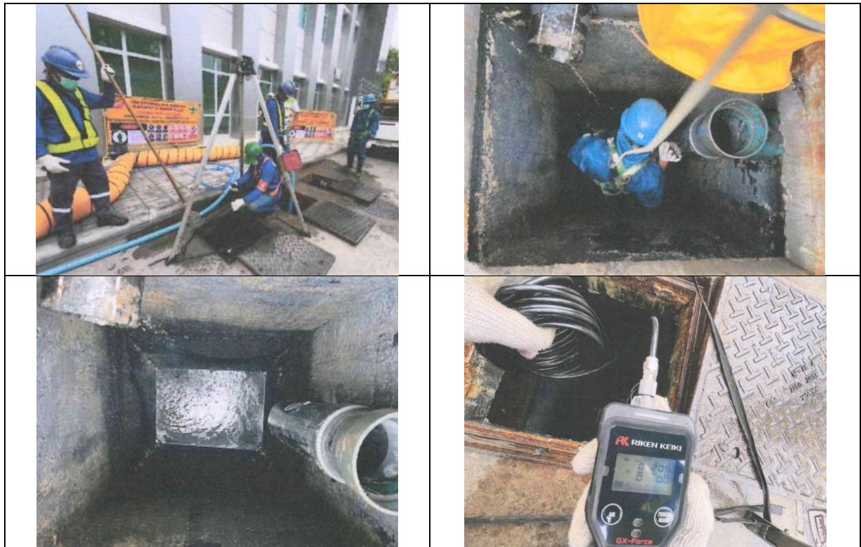
รูปที่ 2-11 การตรวจสอบและสูบลากไขมันในบ่อดักไขมัน
